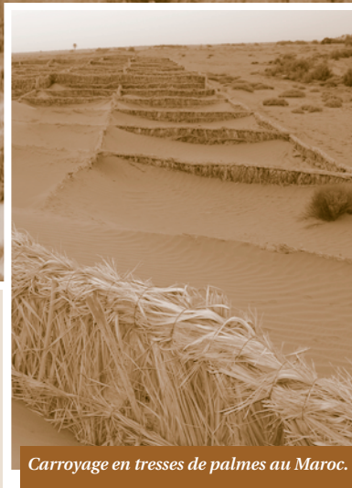
Fixation de dunes dans les oasis du Maroc combinant fixation mécanique (quadrillage) et biologique (arbustes).
